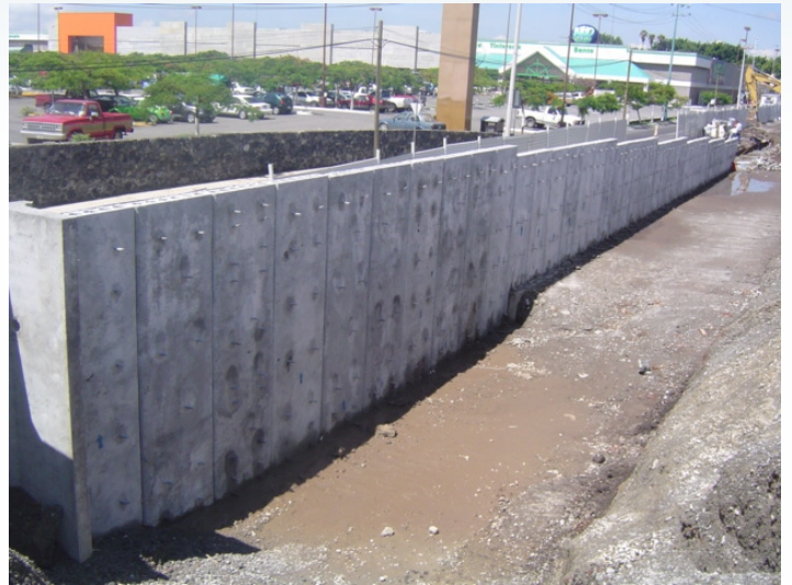
Muros de tierra mecánicamente armada
