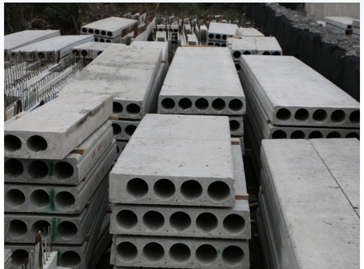
Estibado de piezas en obra
