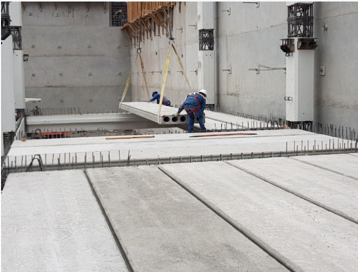
Colocación en posición de la pieza
