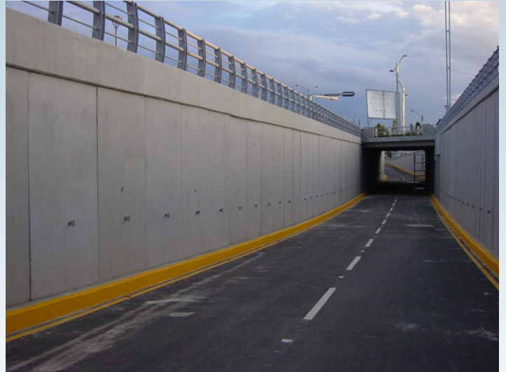
Muros de contención
