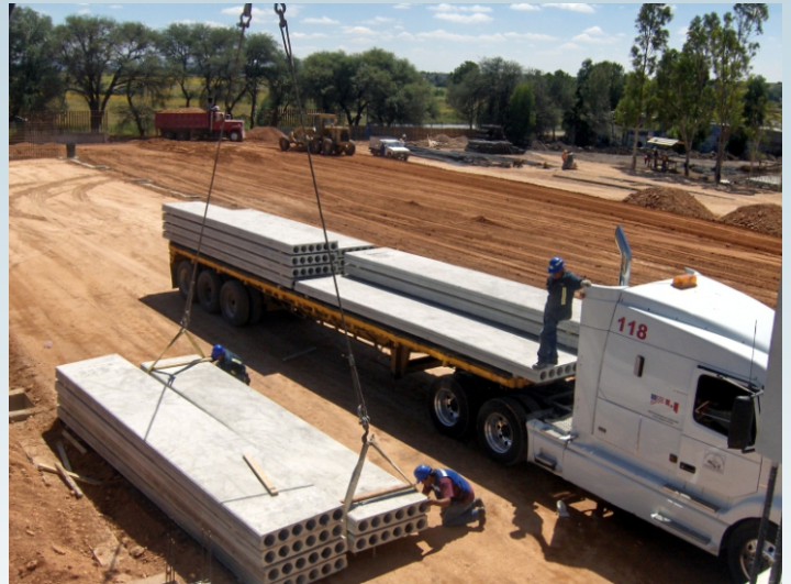
Transporte de piezas al lugar de la obra
