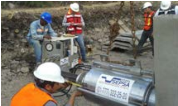
Servicio de Postensado.
