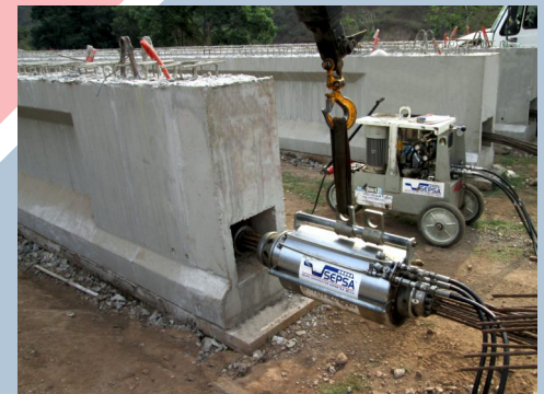
Postensado de losas, trabes, cabezales y dovelas
