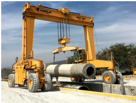
Producción de piezas de concreto
